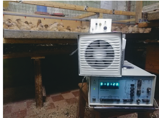
Рис. 3. Проведение испытаний комбинированной электроустановки в птицеводческом помещении
